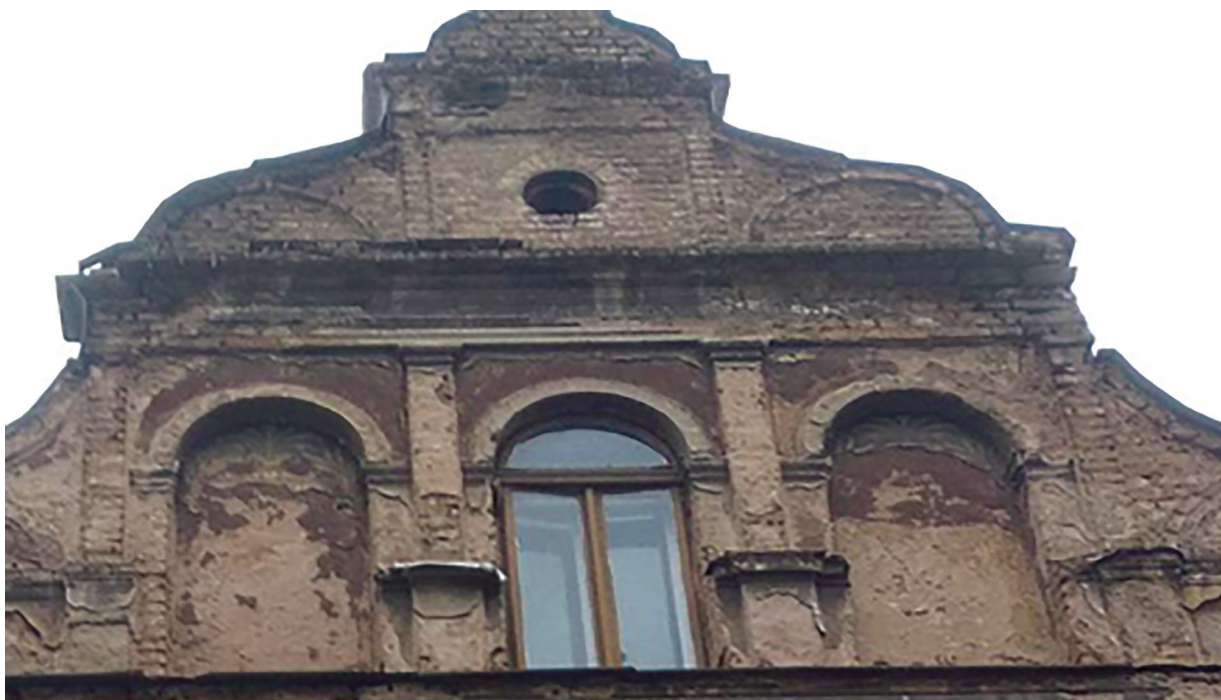
Slika 18. Sjeverna fasada - potkrovni dio prije restauracije
