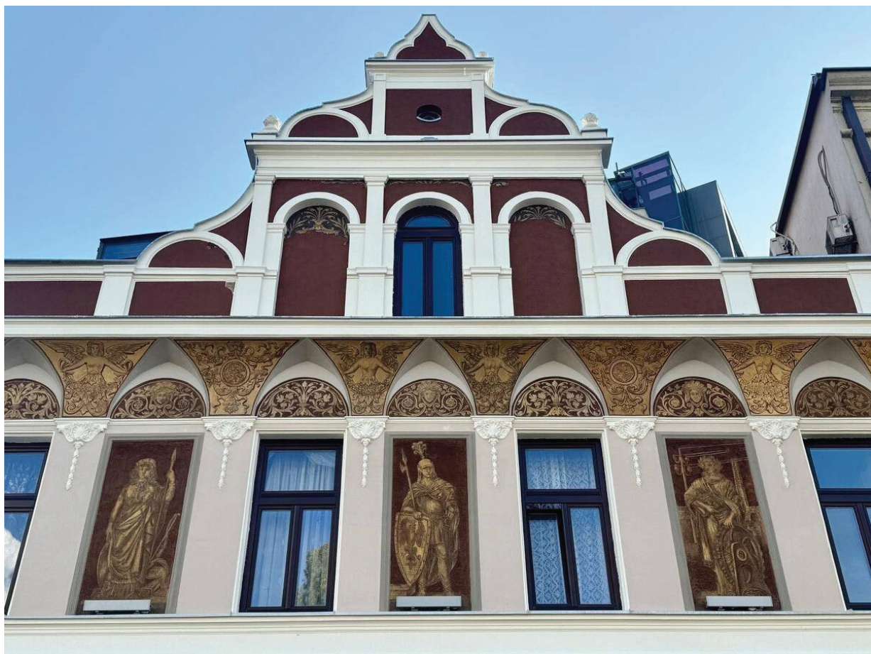
Slika 27. Fasada poslije restauracije
