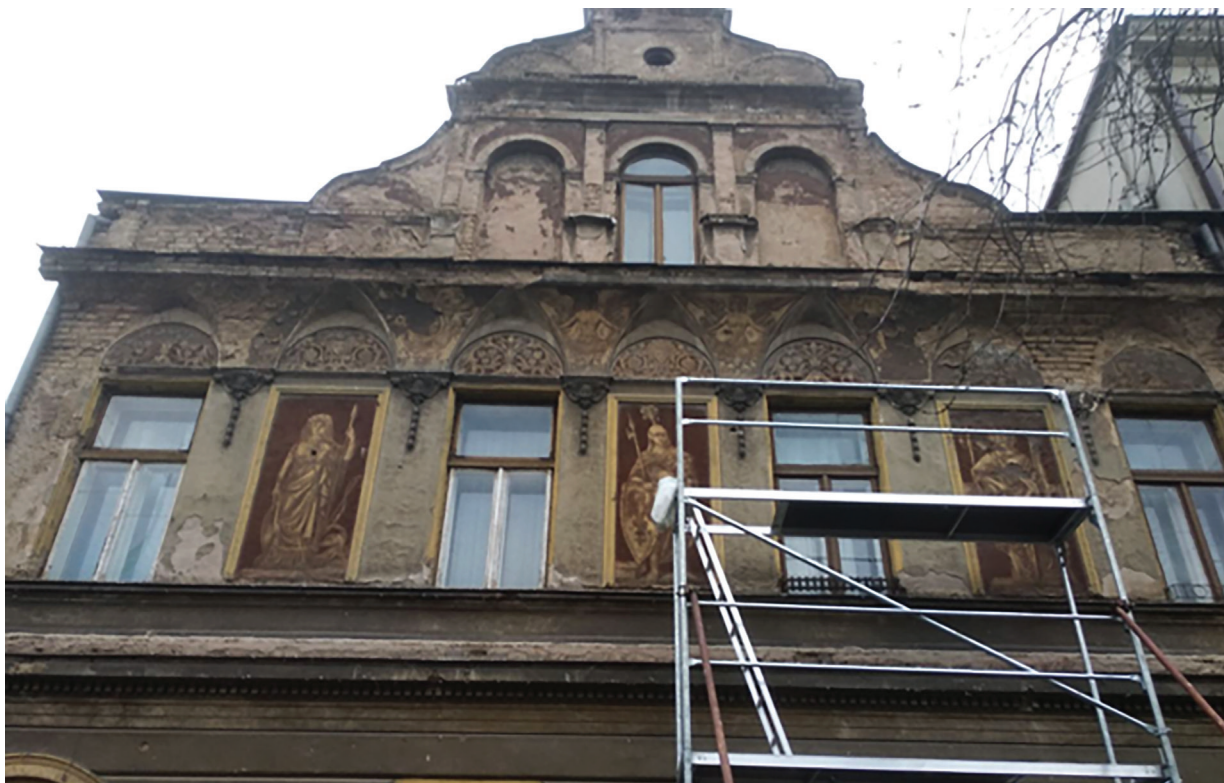
Slika 2. Dio sjeverne fasade, I sprat i potkrovlje
