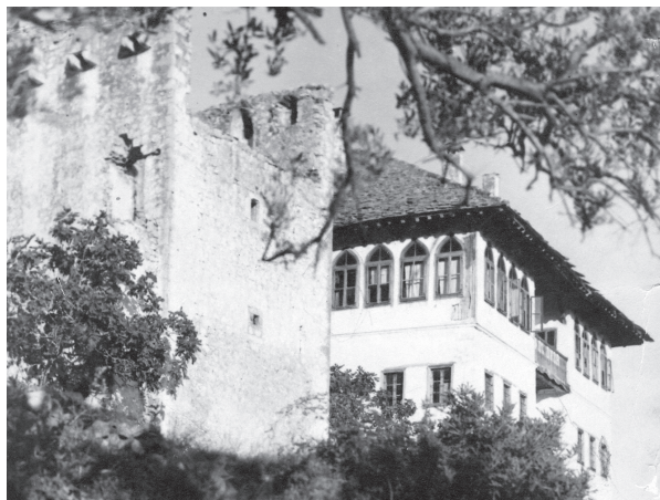
Sl.2. Stambena kula i dvorac Kapetanovića između dva svjetska rata, pogled sa zapada. Na stambenoj kuli izgorio je zadnji sprat, doksat na drugom spratu, te svi ostali drveni elementi. Stara fotografija nepoznatog autora.
