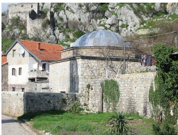
Hamam uz Šišman Ibrahim - pašinu džamiju u Počitelju nakon završenih konstruktivnih radova na zidovima i kupoli (2024. godine foto Azer Aličić)
