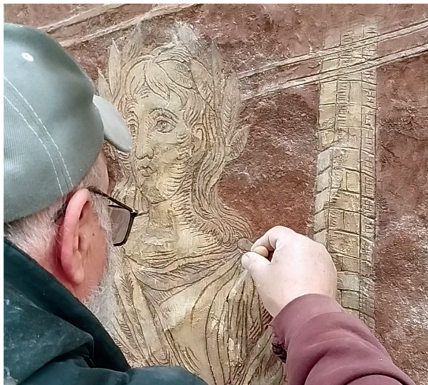
Slika 19. Injektiranje
