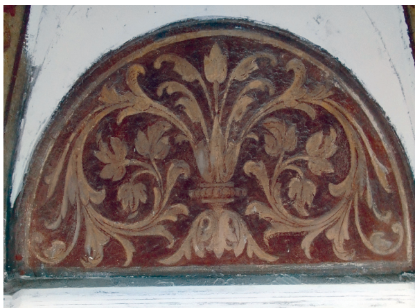
Slika 22. Dio zgrafita nakon čišćenja
