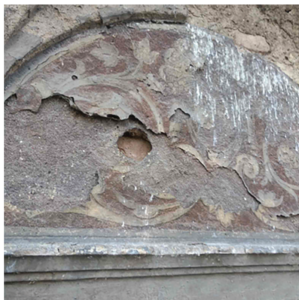
4. Ljuspanje i raslojavanje bojenih slojeva zgrafita – oštećenja – ratno oštećenje.
