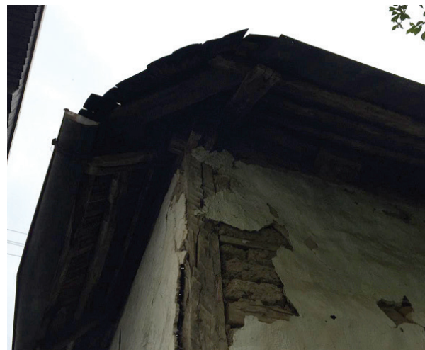
Slika 9. Kuća obitelji Buljina u selu Majdan kod Fojnice. Lijevo: međukatna konstrukcija prizemlje-kat (u mutvaku i huđeri). U sredini: međukatna konstrukcija prizemlje-kat (u sobi). Desno: međukatna konstrukcija kat-tavan (u prostoru čardaka) Izvor: Autor (19. juna 2016.)
