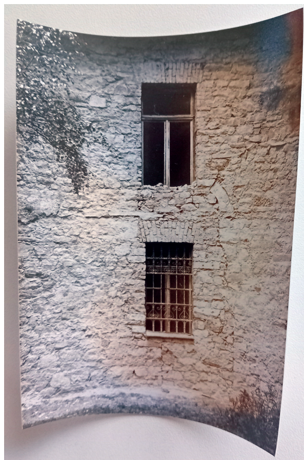
Sl.5. Oštećenje vlagom i tzv. hrđa na fotografiji (pojava žutih fleka)
