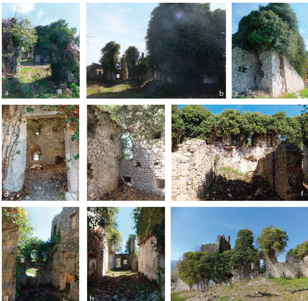
Sl.17. Fotografije postojećeg stanja: a .glavni ulaz u graditeljsku cjelinu; b. pogled na stambenu kulu (desno) i dvorac (lijevo) iz avlije; c. stambena kula sa zapada; d. ulaz u stambenu kulu; e. enterijer stambene kule; f. sjeveroistočno krilo dvorca; g. jugozapadno krilo dvorca; h. centralni hol-hajaj dvorca; jugoistočna fasada dvorca. Komisija za očuvanje nacionalnih spomenika, Vitina: 2017.
