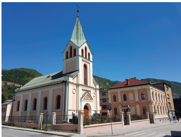
Sl.2. Pogled na graditeljsku cjelinu
