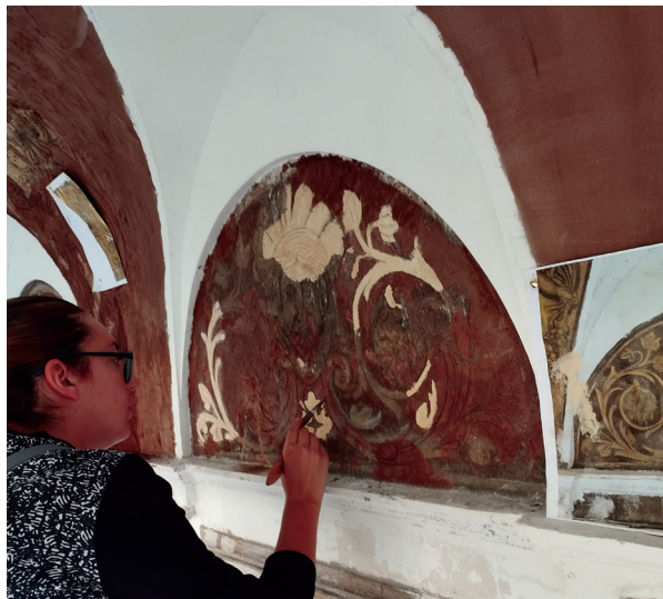
Slika 20. Nanošenje i obrada maltera
