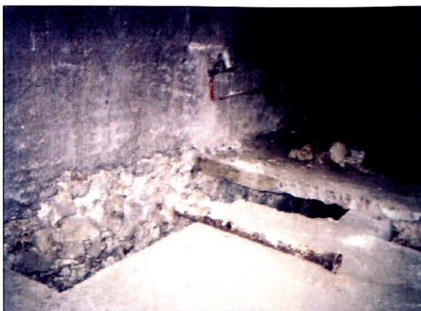
Slika 10. Kapi – kula Ploča, februar – mart 2005.g.- u periodu izvođenja prve faze istražnih radova. Foto gore i dole: nakon čišćenja unutrašnjosti kule Ploča, izvedeno je sondiranje betonske ploče u zoni tjemenca svoda, čitavim poprečnim profilom. Na fotografijama je posebno uočljiv nivo devastacije unutrašnjosti kule: zidovi prekriveni cementnim malterom i betonska ploča poda. Ispod maltera se, u komorama, vidi originalni kameni zid.
