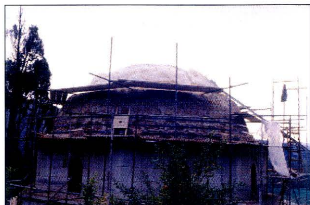
Sl.7 – Ojačanja kupole provedena su ugradnjom karbonskih vlakana
