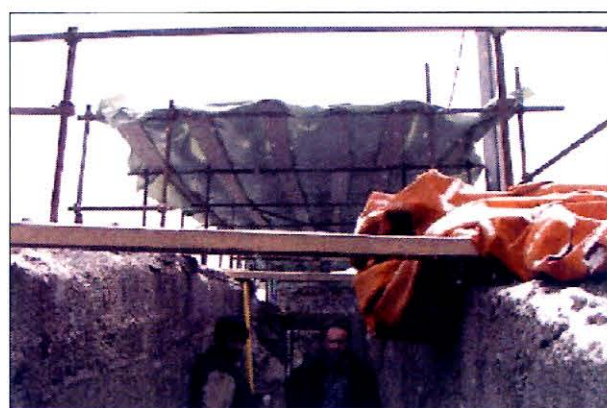
Slika 13. Bedem u toku radova. Nakon pažljivog odstranjivanja armiranobetonske ploče, započeli smo s utvrđivanjem stanja i snimanjem unutrašnjosti bedema. Radovi su vođeni u kasnu jesen, te nam je, u dinamici, cilj bio da sva istraživanja okončamo prije zimskog prekida građevinske sezone, kako bismo u periodu privremene obustave, mogli raditi na eventualnim prilagodavanjima dokumentacije. U novembru su, međutim, počele padavine; snijeg je, povremeno, ometao radove, te su izvedene zaštitne natstrešnice.
