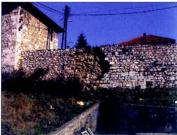
Slika 9. Bedem između kapi - kula, decembar 2004.g.-januar 2005.g.- u periodu izrade projektne dokumentacije. Dio zida na kojem su osuti blokovi lica osuti. Ovdje je postojala i kaverna, kroz koju smo vidjeli šupljinu i ustanovili postojanje unutarnje komore.
