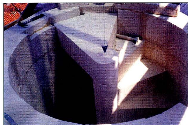
Sl.8 – Radovi na rekonstrukciji minareta
