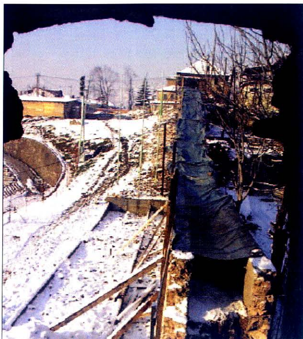
Slika 17. Pogled na bedem od kule Širokac ka kuli Ploča u toku prve faze radova – (istražni iskopi i odstranjivanje betonske ploče)
