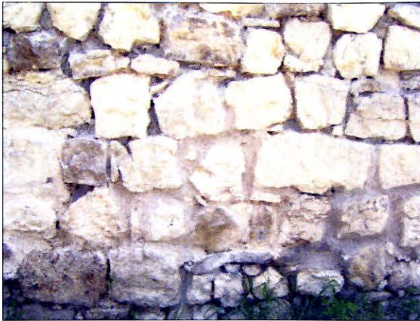
Slika 18. Konzervatorske probe: jedan od 12 napravljenih uzoraka maltera za dersovanje kamenih zidova.
