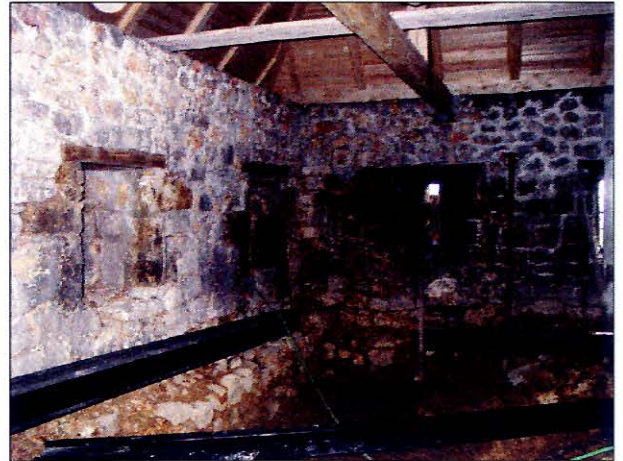
Slika 20. Unutrašnjost prostorije na spratu kule Širokac u toku radova. Krovna konstrukcija je završena, i na objekat su dopremljeni čelični nosači konstrukcije poda
