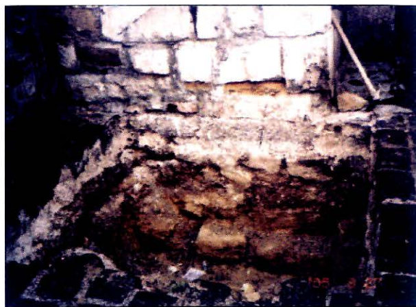
Slika 12. Kapi – kula Ploča, februar – mart 2005.g.- u periodu izvođenja prve faze istražnih radova. Sondiranje temelja, tj., kopanje manjih istražnih jama, imalo je cilj da se utvrdi dubina fundiranja, stanje i grada temelja, te kvalitet i vrsta temeljnog tla. Na fotosu se vidi sonda uz zapadni zid, u kojoj se može uočiti da je on tu vrlo plitko fundiran, na ilovači s velikim procentom glina. Mjereno cca 1,20 od gornje kote terena, još uvijek nismo naišli načvrsto tlo / substrat, te smo zaključili da je ovo jedan od inicijalnih uzroka pojave pukotina, koji zahtijeva ozbiljan sanacioni zahvat.
