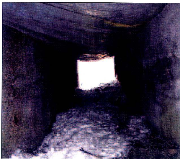
Slika 15. Bedem u toku radova. Prema kuli Širokac, visina od čvrste ispune do krune bedema znatno je opadala, i, po formi i dimenzijama „korita“, funkcionalno odgovarala stražarskoj rampi. Na ovom dijelu, projektnim rješenjem smo predviđeli otvoreni obhod bedema
