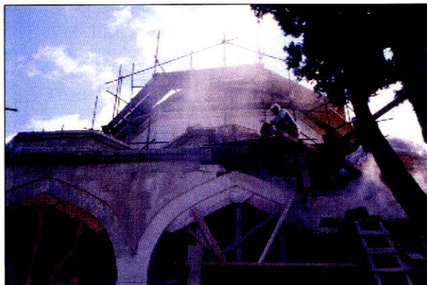
Sl.4 – Radovi na obnovi potkupolnog trijema i kupole nad molitvenim prostorom
