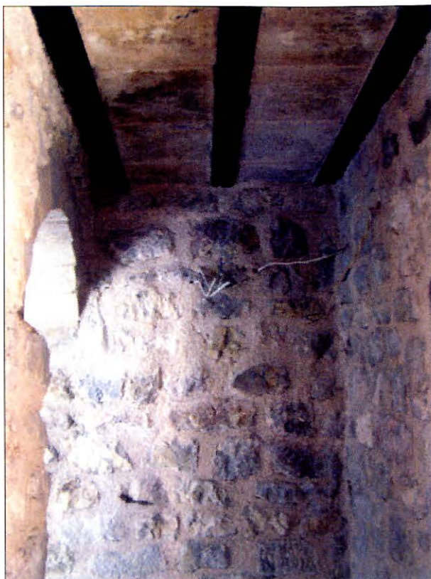
Slika 27. Kula Ploča, zasvedeni novoprojektovani hodnik u južnom zidu, kroz koji se ulazi u unutarnji prostor bedema.. Akcenat je bačen na originalne zidove, a novi elementi su diskretno naglašeni razlikom u finalnoj obradi materijala: sedreni blokovi koji čine ispunu „tavanice“, samo su obrušeni. Nosiva konstrukcija izvedena je od savremenih čeličnih nosača neutralnog dizajna
