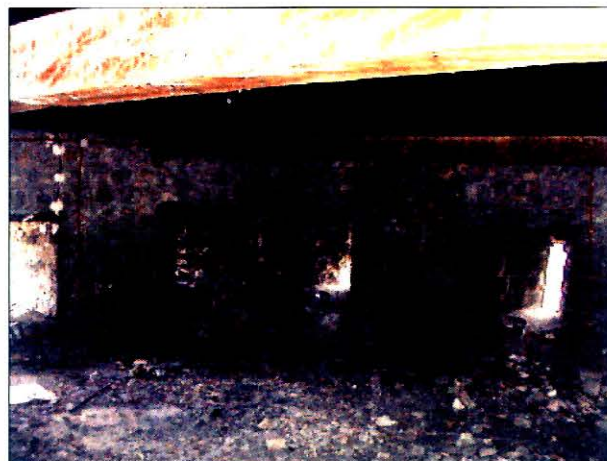
Slika 4. Unutrašnjost kule Širokac, decembar 2004.g.-januar 2005.g., u periodu izrade projektne dokumentacije. Vidljive intervencije cementnim malterima u spojnica, kablovi, te sloj šuta na podu prostorije.
