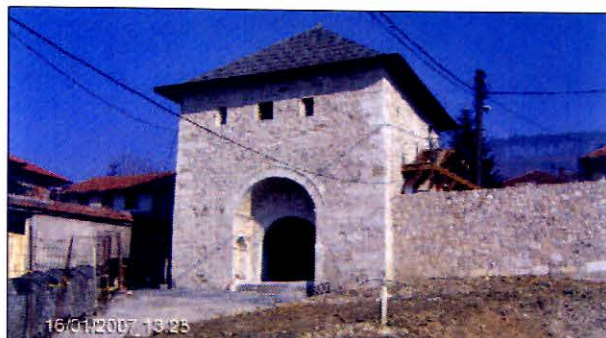
Slika 25. Kula Ploča nakon završetka radova obnove, eksterijer. Preostala je još samo montaža ulaznog portala.
