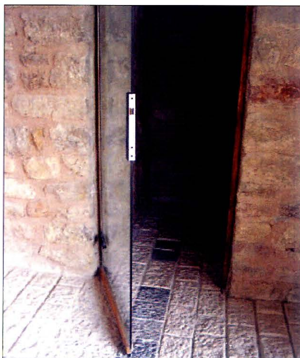
Slika 26. Prizemlje kule Ploča nakon završetka radova obnove, enterijer – prostor recepcije. Sponu između različitih perioda ostvarili smo kombinacijom materijala: kamena po uzoru na prvobitni, s kamenom kojim je on, u jednom, relativno dugotrajnom periodu njenog postojanja, zamijenjen. Ploče od autohtonog krečnjaka – hreše, oblikovali smo savremeno, složivši ih u nišama u diskretne ornamente, a, prethodno demontiranom postojećom granitnom kockom, u parteru "nacrtali" hodne linije posjetilaca.
