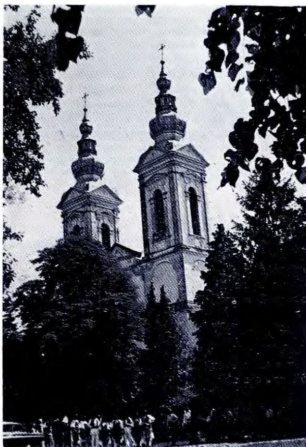
Sl. 7 Zapadno pročelje samostanske crkve u Tolisi
