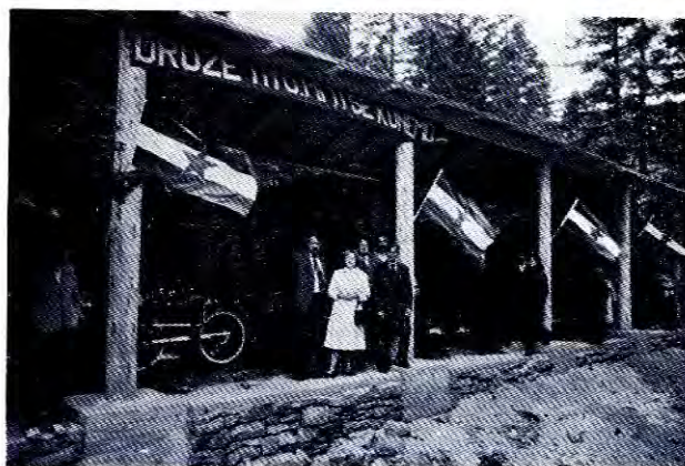
Prednji dio nastrešnice sa lokomotivom »Proleterkom broj 12« za vrijeme svečanosti na Oštrelju 11. oktobra 1942. godine
