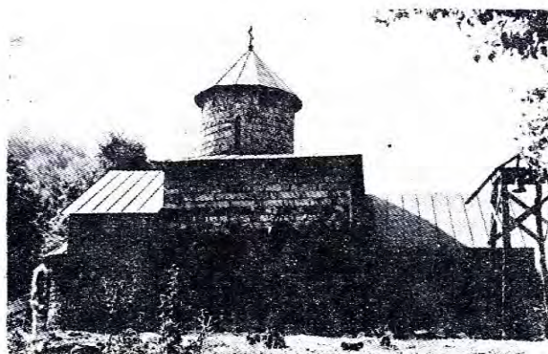
Izgled crkve manastira Rmnja (sa severne strane), posle rekonstrukcije izvedene 1980. godine. (snimak Z. Kajmaković).
