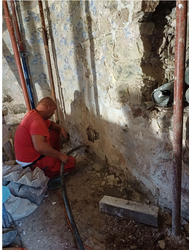
Slika 25., Injektiranje unutrašnjih zidova injekcionom masom Roefix SismDur Iniezione 15
