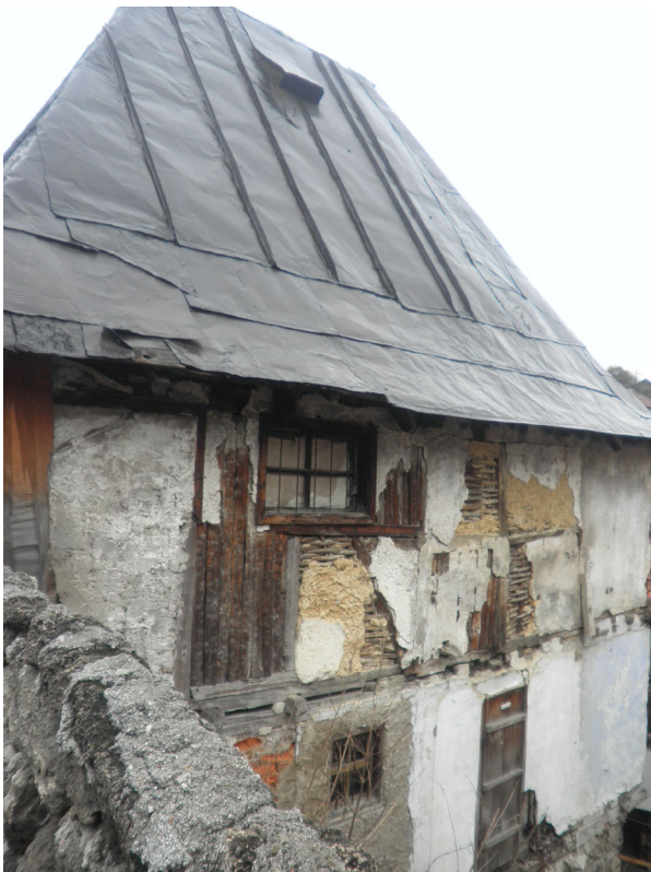
Zapadna fasada sa brojnim detaljima konstrukcije
