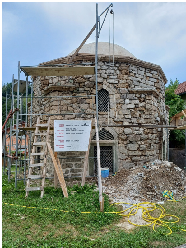
Sl. 16 Početak radova sanacije na Semiz ali pašinom turbetu u Prači
