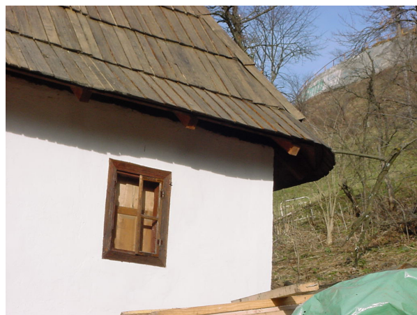
Rijedak primjer izrade polukružno obradene strehe
