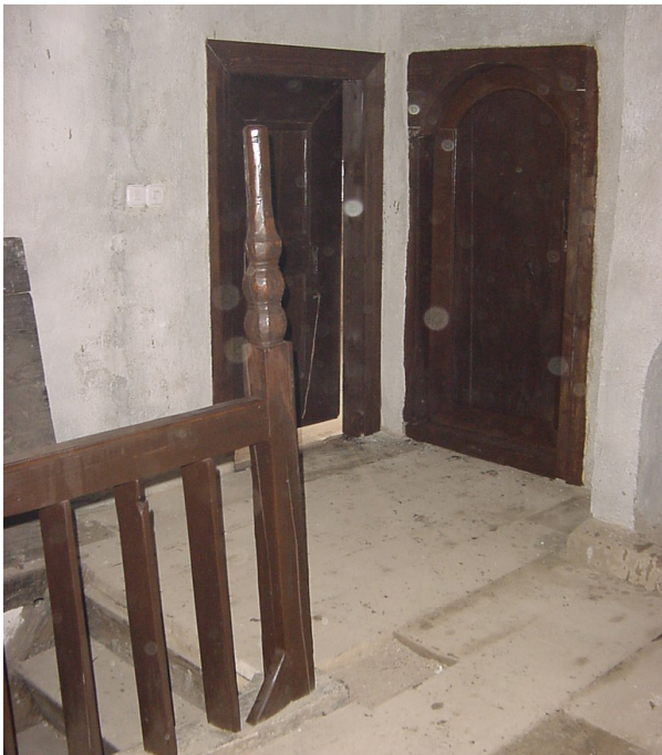
Završeni radovi enterijera na spratu
