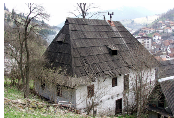
Zatečeno stanje objekta
