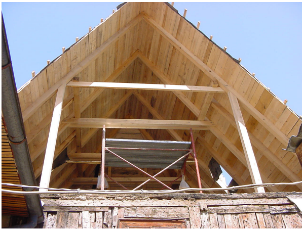
Izrada krovne konstrukcije 2004 godine
