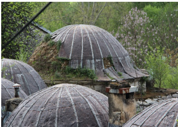
Uništeni pokrov kupole i kupola medrese
