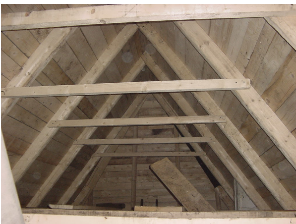
Završeni radovi na izmjeni krovne konstrukcije objekta.
