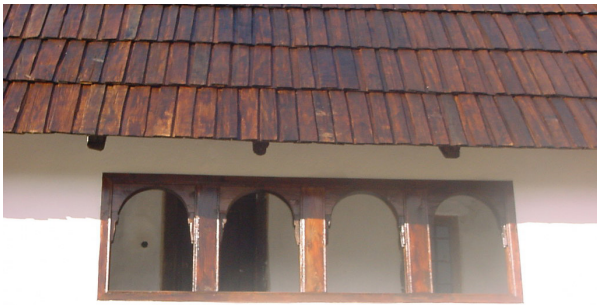
Detajl prozora nakon rekonstrukcije, 2002. godine
