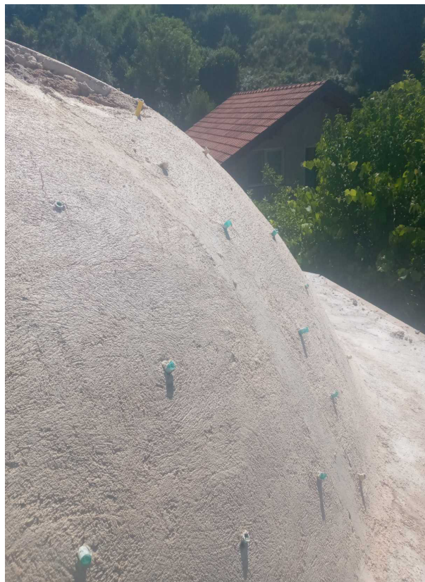
Slika 27., Omalterisana vanjska strana kupole sa ostavljenim pakerima za injektiranje
