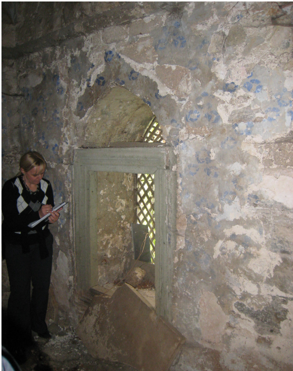
Sl. 13 Uočljivi su ostaci oslikavanja na malteru i ukrasnih profilacija na donjim doprozornicima.
