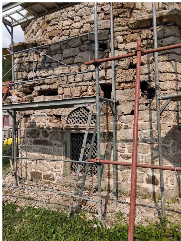
Slika 23., Čišćenje i obnavljanje fuga na vanjskoj strani zidova
