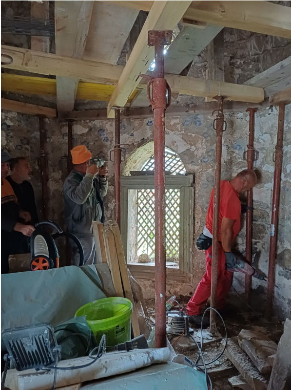
Slika 24., Bušenje rupa za injektiranje zidova
