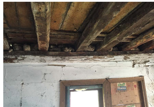
Slika 6. Kuća Kršlak 02 u Jajcu. Lijevo: međukatna konstrukcija prizemlje - prvi kat (vidljiva u prostoru trijema). Desno: međukatna konstrukcija prizemlje – prvi kat (vidljiva u prostoriji, u prizemlju) Izvor: Autor (24.8.2016.)
