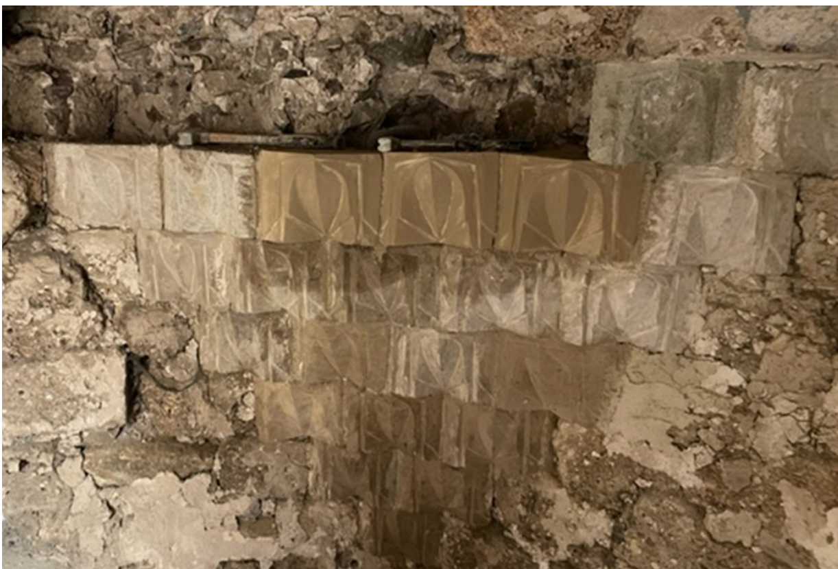
Slika 30., Ugradnja nedostajućih dijelova mukarnasa
