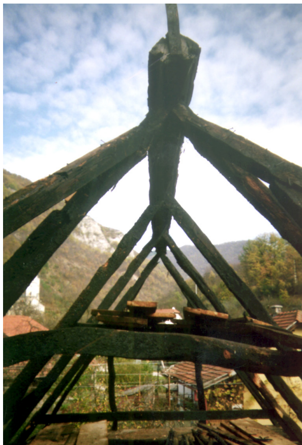
Zatečena krovna konstrukcija
