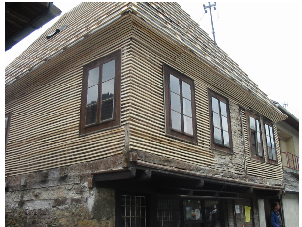
Prikaz radova izrade ispune bondručnih zidova drvenim letvicama 2x2cm
