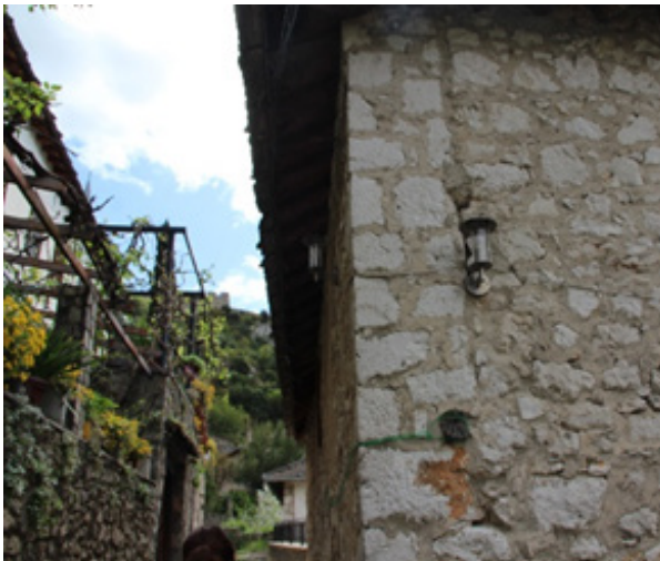
Ulična svjetiljka na ogradnom zidu i zidu objekta
