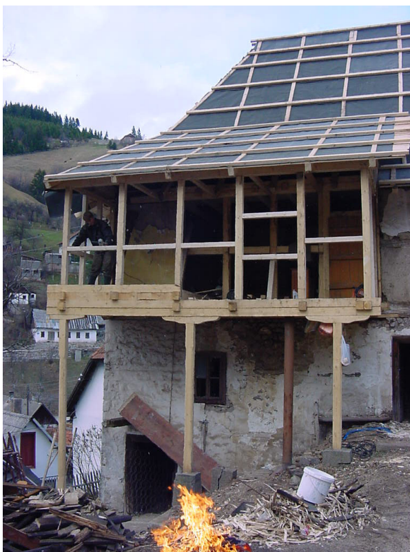
Završni radovi rekonstrukcije konstrukcije verande
