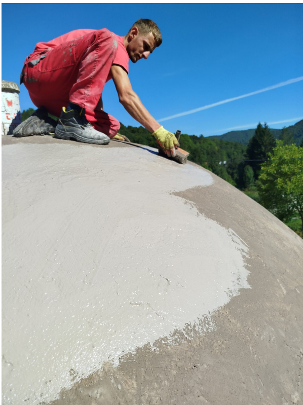
Slika 28., Nanošenje hidroizolacionog sloja po omalterisanoj površini kupole
