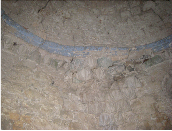
Sl. 8 Oštećenja na mukarnasima, zatečeno stanje 2010. godine
