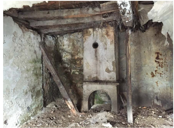
Slika 11. Kuća Kršlak 02 u Jajcu. Kamin ('kahve odžak') u sobi (u prizemlju). Izvor: Autor (24.8.2016.)
