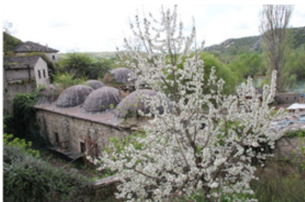
Uništeni pokrov kupole i kupola medrese
