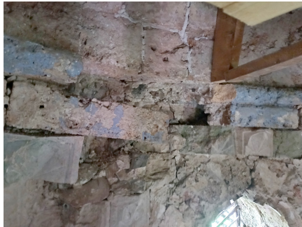
Sl.11 Zatečena oštećenja na dekorativnom vijencu iz 2024. godine
