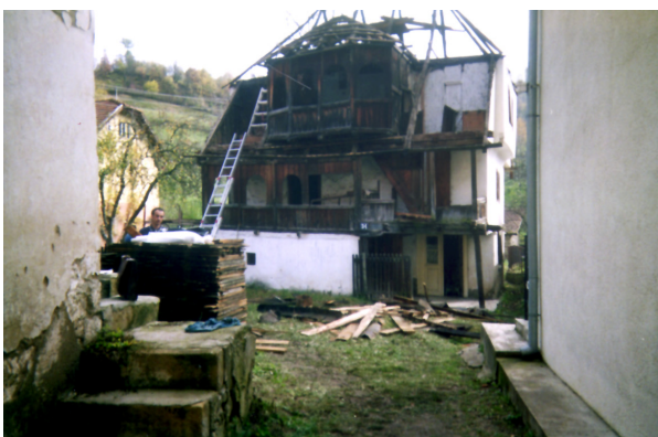
Radovi na demontaži krovnog pokrivača - šindre
