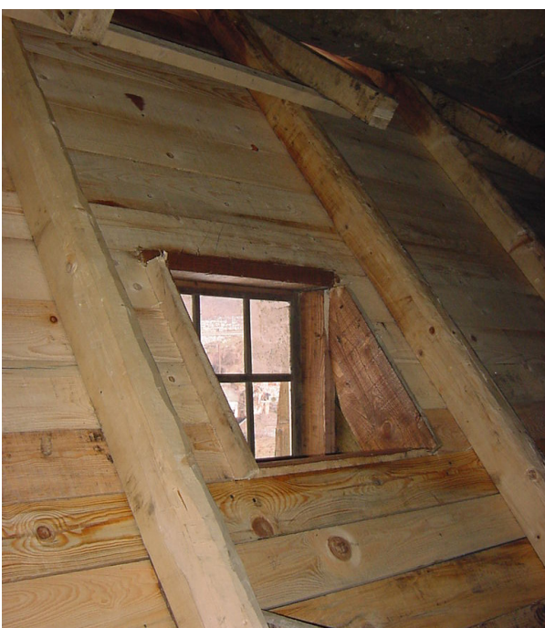
Detalj krovne badža za ventilisanje krova
