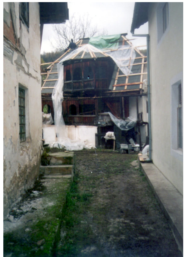
Objekat spreman za ugradnju šindre
