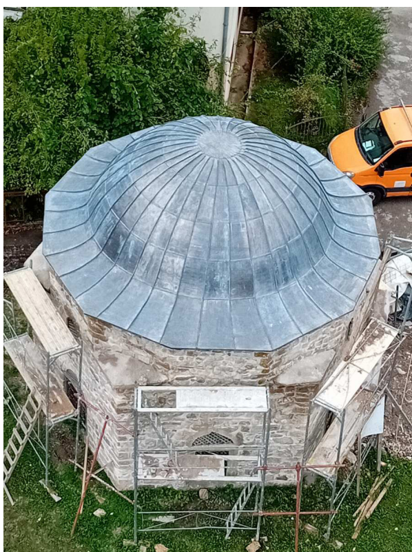
Sl. 18. Završeni radovi na pokrivanju kupole
