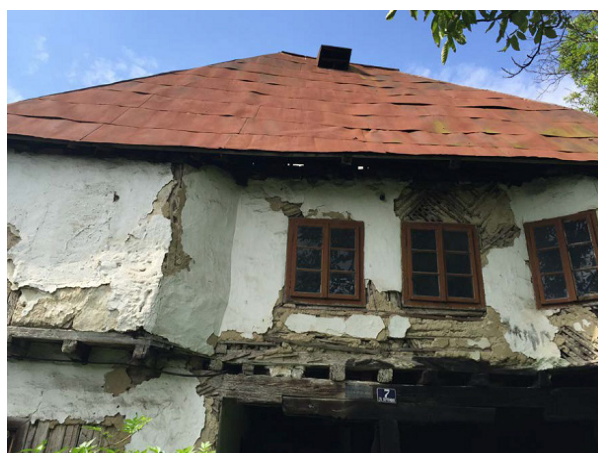
Slika 4. Kuća Kršlak 02 u Jajcu. Detalji konstruktivnog sklopa kuće; Izvor: Autor (24.8.2016.)
