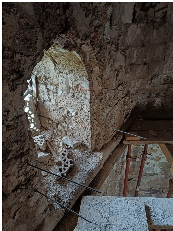
Slika 29., Ojačanje zida navojnim šipkama M8 u području prozorskih otvora
