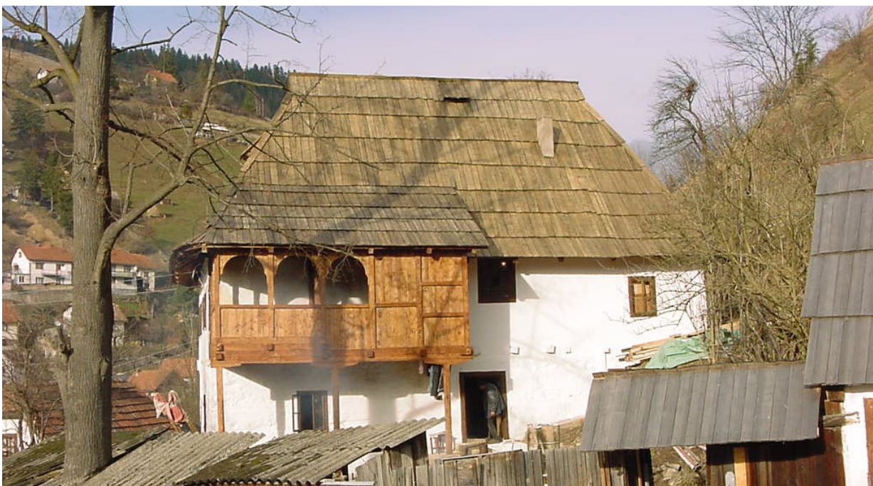
Završena rekonstrukcija objekta 2003. godine
