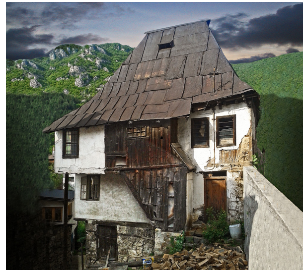
Istočna fasada Korkuta kuće
