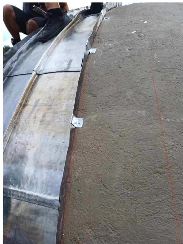
Sl. 17. Detalj pokrivanja kupole olovnim limom
