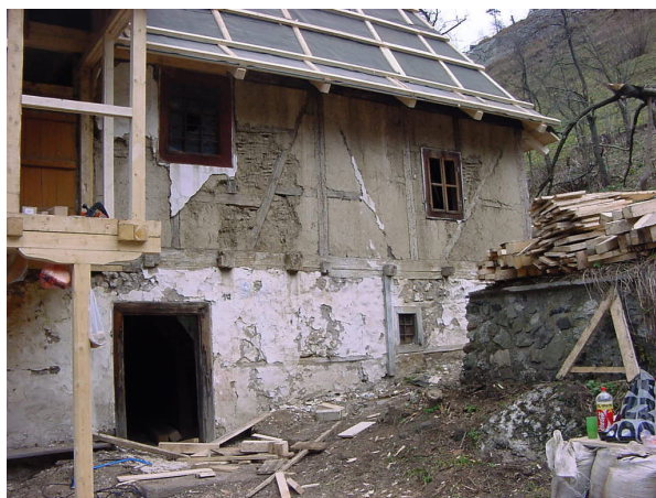
Zidovi prizemlja i sprata rađeni u bondruk sistemu sa ispunom od šepera
