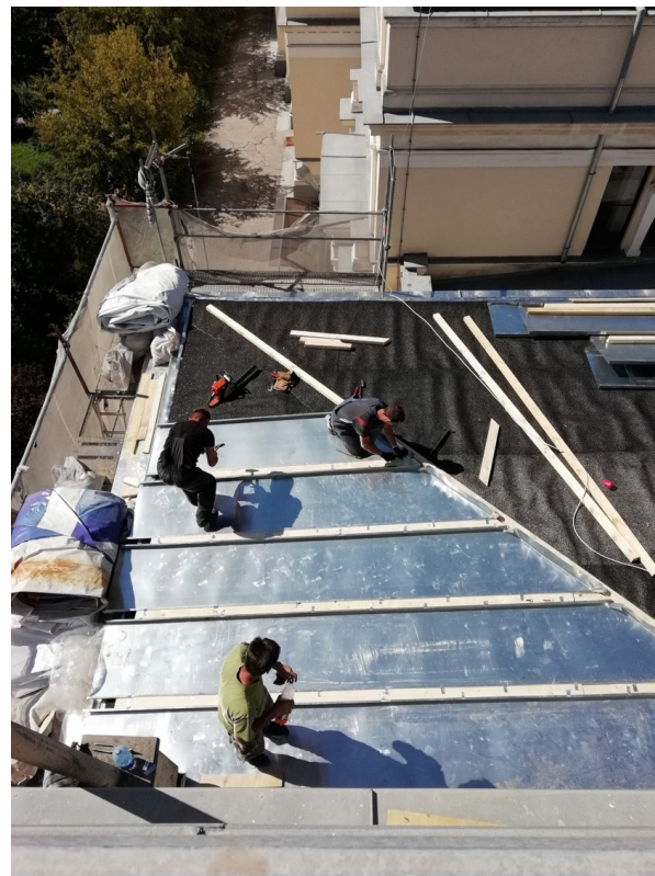
Radovi na krovu
