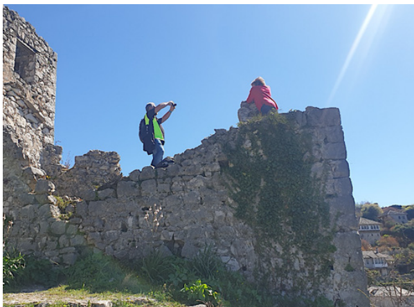
Turisti na izuzetno nestabilnoj zidanoj strukturi ravougaone kule sa rasutom krunom zida i otvorom u podu
