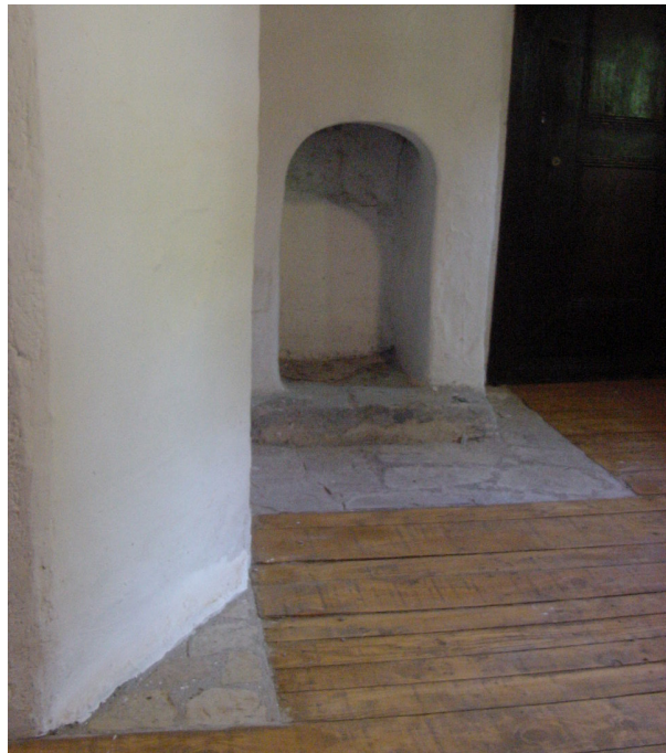
Detalj uzidane peći na spratu objekta
