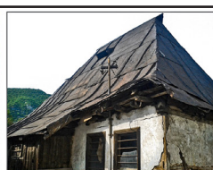
Šeper – skeletni zid od prepletenog kolja i pruča sa ispunom od zemlje
