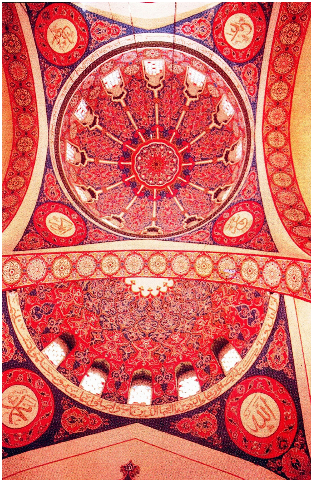
Sl. 2. Izgled kupole sa pandantifima Ferhad-pašine džamije nakon restauratorsko-konzervatorskih radova iz perioda 1972.–75. godine
