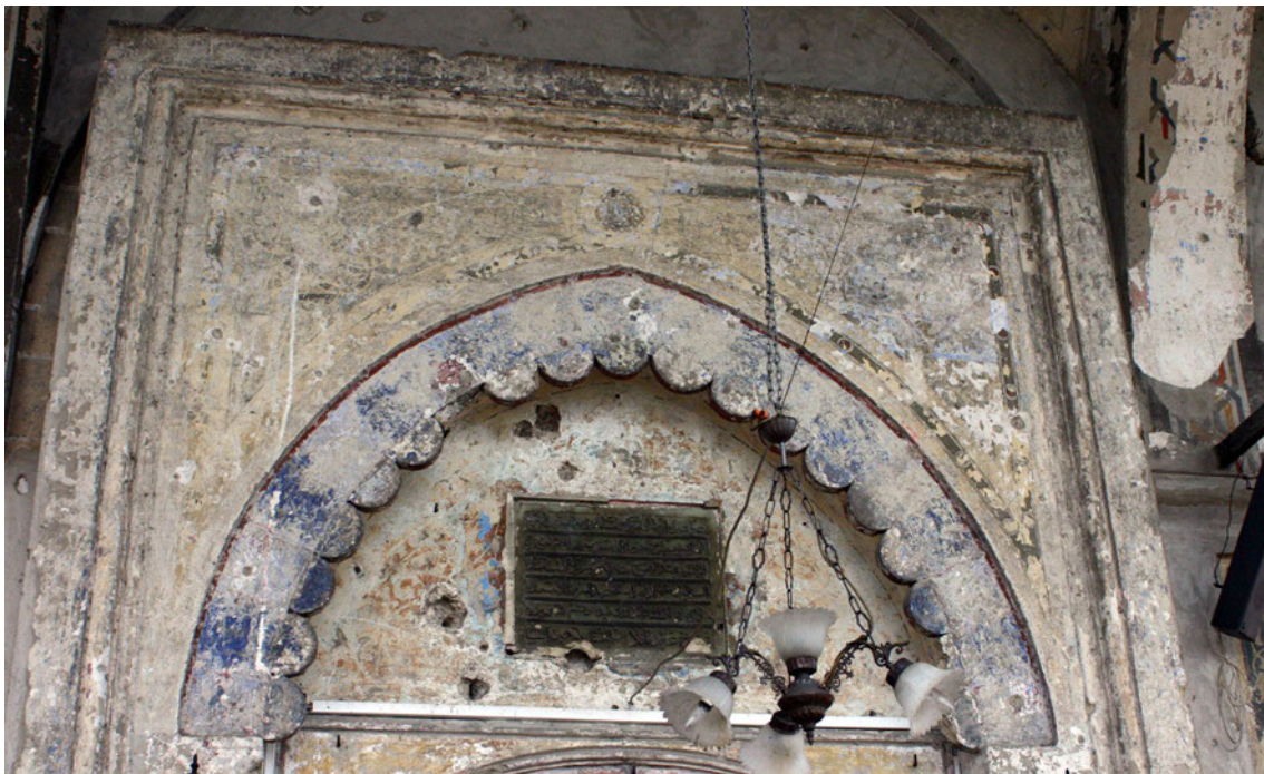
Sl. 13. Vanjski portal
