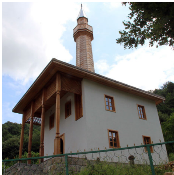
Džamija u Čojluku, izvedeno stanje
