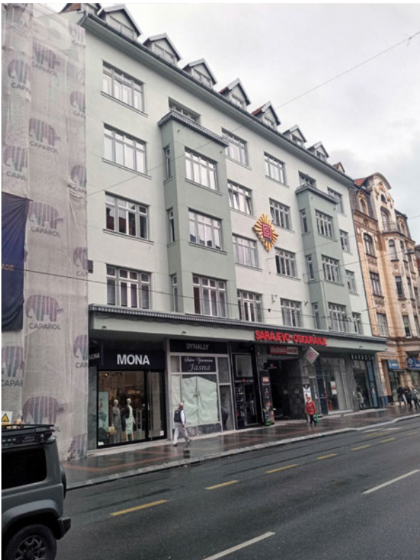
Fasada u Titovoj na broju 29, nakon intervencije
