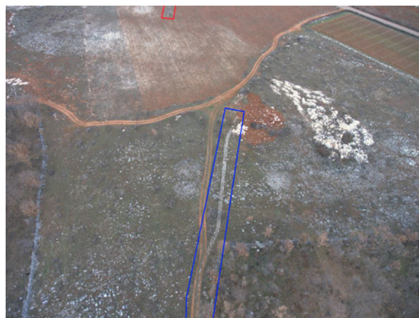
Popločana staza (označeno plavom na slici) i popločana rimska cesta (označeno crvenom na slici) na poddionici Buna Počitelj (fotografiju izradili: Tino Tomas i Mirko Rašić)
