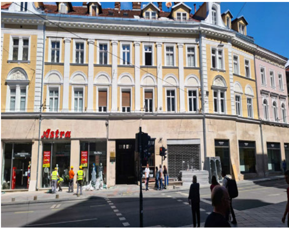
Fasada na objektima u ulici Titova 33 i Kaptol 1., nakon sanacije
