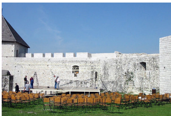
Detalj odvodnje vode sa platoa iznad kazamata
