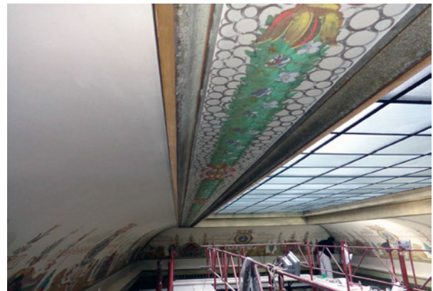
Horizontalni svjetlarnik, horizontalni obrub i zasvođeni dio stropne konstrukcije iznad centralnog prostora, Sarajevo, 2018.
