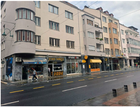
Sanacija fasada u Titovoj ulici na proju 17, 19 i 21
