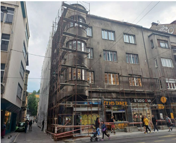
Fasada u Titovoj ulici na broju 17 i Pruščakovoj 1, zatečeno stanje
