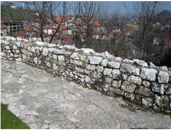
Izgled kruništa, zatečeno stanje
