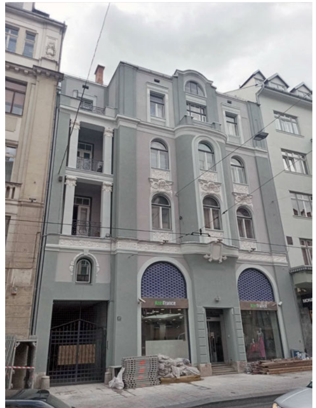
Fasada na broju 27 nakon sanacije
