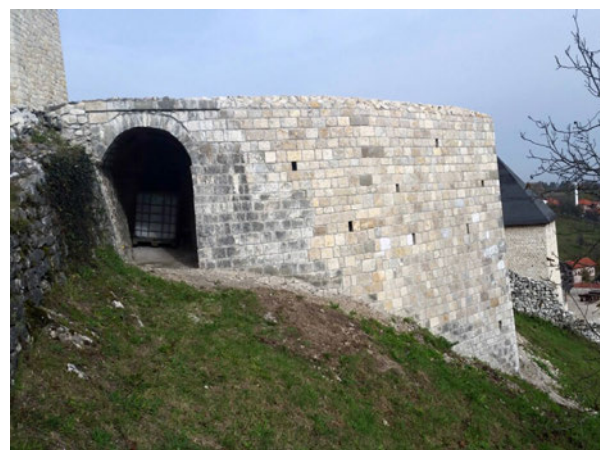
Topovska tabija nakon sanacije
