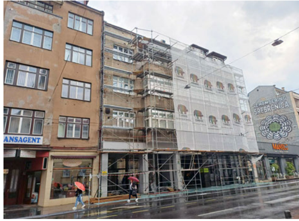
Objekat u Titovoj ulici na broju 21, radovi u toku
