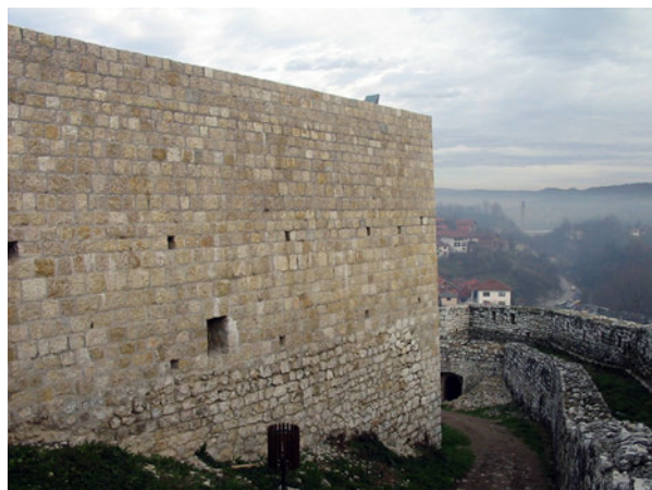
Tabija ispred Dizdareve kule nakon sanacije
