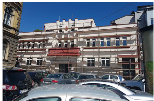
Završni radovi na fasadi, foto 2
