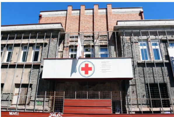
Zgrada Crvenog križa, zatečeno stanje, foto 1
