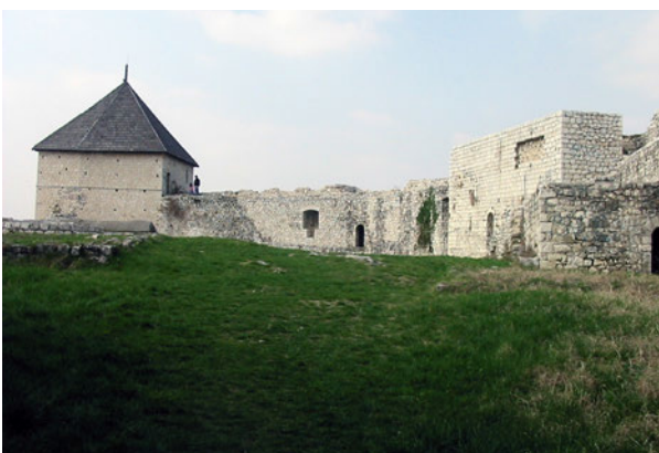
Detalj odvodnje vode sa platoa iznad kazamata
