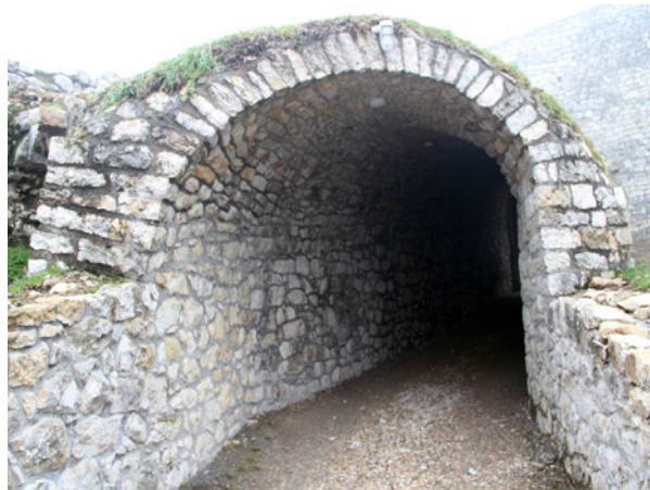
Ulaz u tunel nakon sanacije
