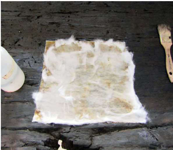
Postavljanje komprese sa acetonom
