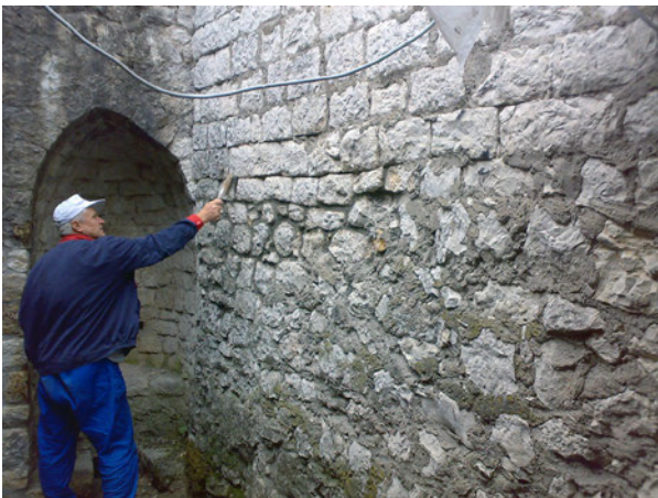
Čišćenje zida čeličnim četkama - priprema za pranje i dersovanje
