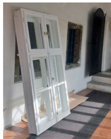
Uzorni primjerak „kutijastog“ drvenog prozora izrađenog kao faksimilska rekonstrukcija postojećeg; 2023.; Foto: Azra Tunović
