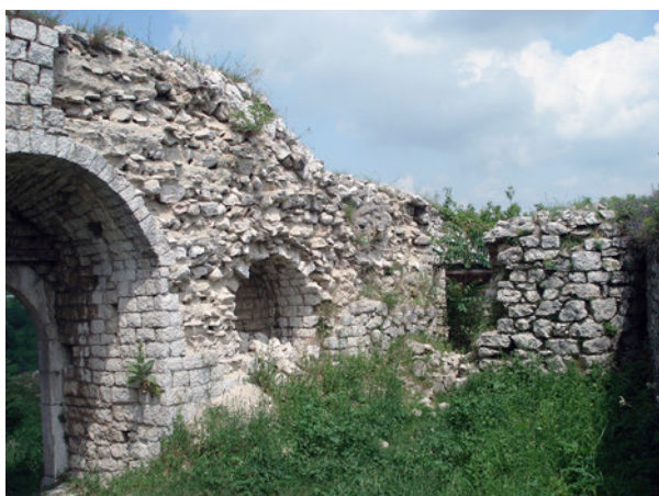
Osmougaona kula, zatečeno stanje
