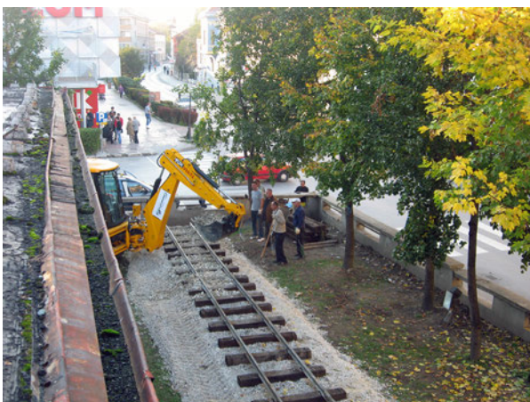
Postavljanje kolosjeka sa novim zastorom i pragovima u dvorištu Muzeja
