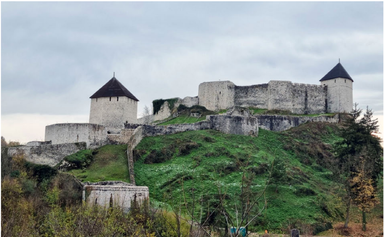
Stari grad Tešanj nakon sanacionih i konzervatorskih radova
