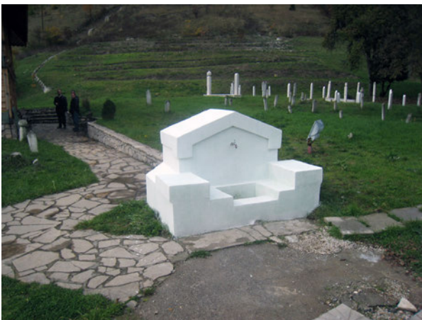
Betonsko korito, zatečeno stanje
