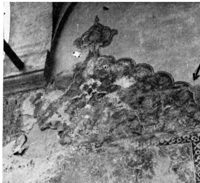
Sl. 14 Lijevo »mihrab« u trijemu Aladže. Strelica prikazuje noviji i originalni završetak. Gore još neočišćene površine
