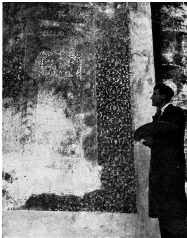
Sl. 19 Desni »mihrab« u toku rada na restauraciji ornamentike. Otkrivene površine originalnog sloja maltera zahtjevale su takođe restauraciju
