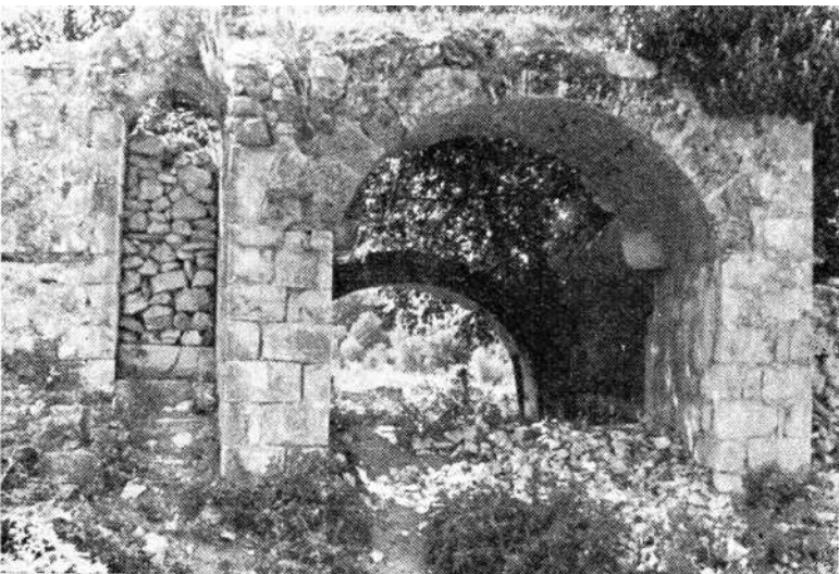
Ostatci monumentalnog ulaza u Šišman Ibrahim-pašin han — pogled sa unutrašnje strane
