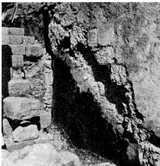
Sl. 6 Jugozapadni ugao crkve prilikom izvođenja izolacije
