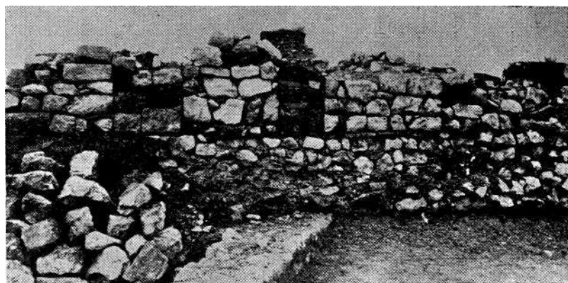
Sl. 4. Temelj i dio zapadnog pročelja s pilastrima i naknadno zazidanim otvorima portika sjeverne bazilike. Snimljeno 1902 godine
