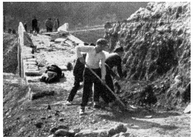
8. Izgled desnog čela mosta u toku skidanja nasipa
