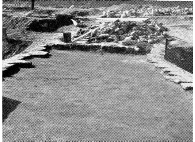
11. Postavljanje cementne košuljice
