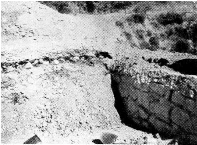
7. Kameni dozidak, zemljani nasip i nova kaldrma na desnoj strani
