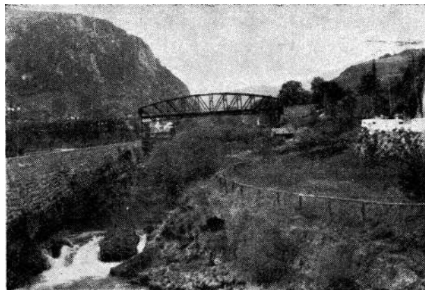
Sl. 3. Zabijanjem pilota kraj obale nabušen je sistem sedrenih inklusa. Voda jodzemno otječe, čime je onemogućen rad sedrotvoraca.
