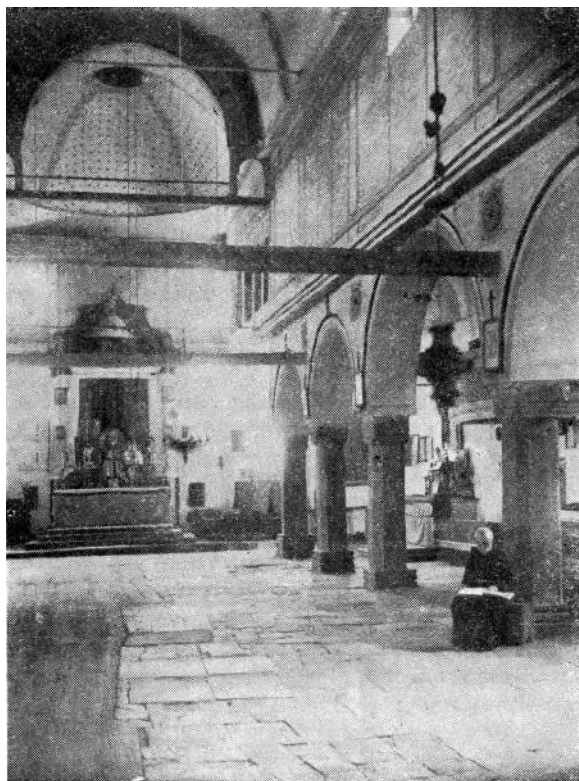
Sl. 2. Unutrašnjost samostana (Foto: Topić, 1907)
