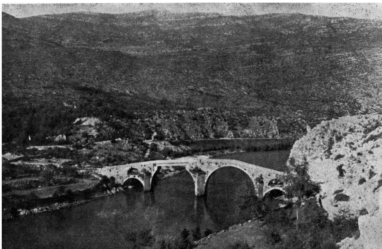
Sl. 12. Arslanagića most kod Trebinja na Trebišnjici. Vidi se porušeno lijevo krilo, nadomješteno betonskom trakom
