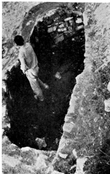
Sl. 27 Havarija na svodu velikog kazamata.
